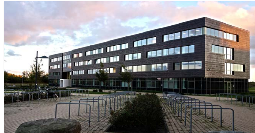
BLICK AUF DEN ERWEITERUNGSBAU „HELSINKI“ (HEL) AUF DEM CAMPUS (FOTO: BERGER)
